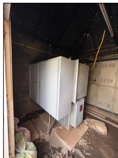
รูปภาพที่ 2.17 หม้อแปลงไฟฟ้าและเครื่องสำรองไฟฟ้า
