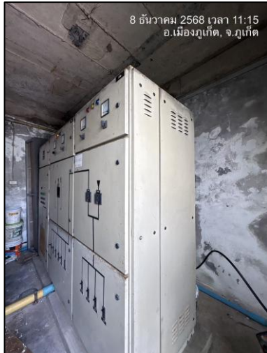
รูปภาพที่ 2.18 Circuit Breaker : CB
